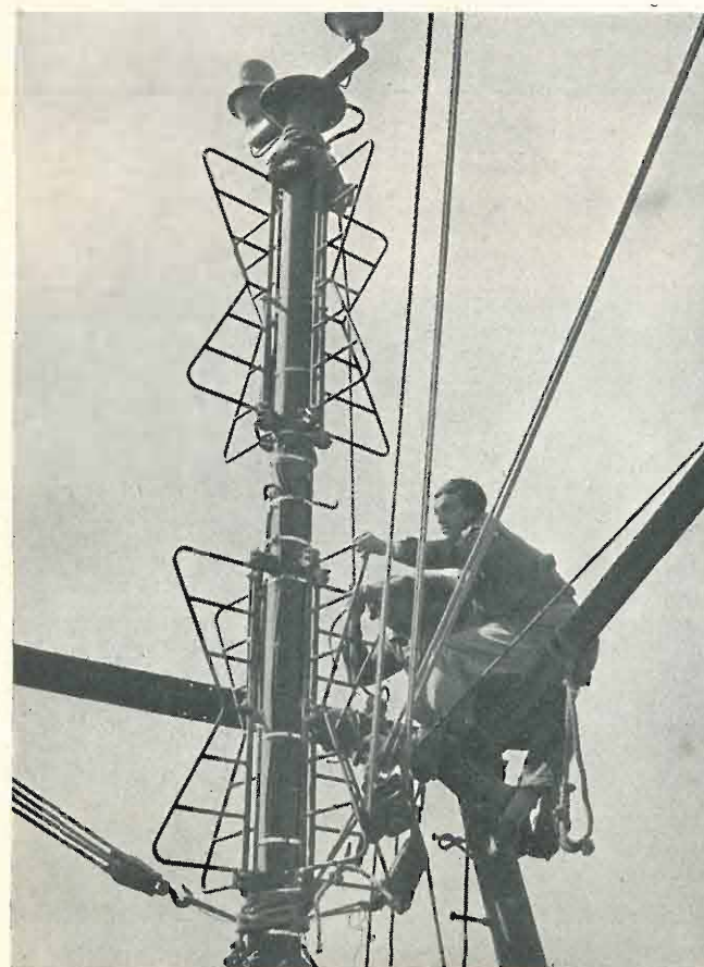
MILANO TV. — La parte superiore del sistema irradiante nella fase di innalzamento.
